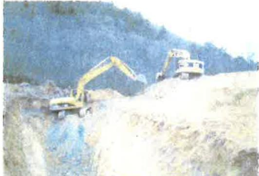
重機を用いた埋却場所の掘削
