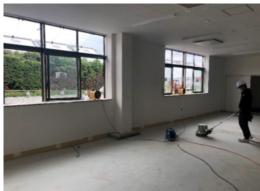
【写真①】送風機による換気(室内側)
