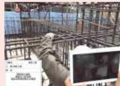
Webカメラを利用した遠隔検査
