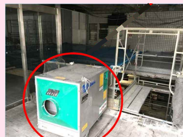
集塵機を設置し室内の換気を実施
