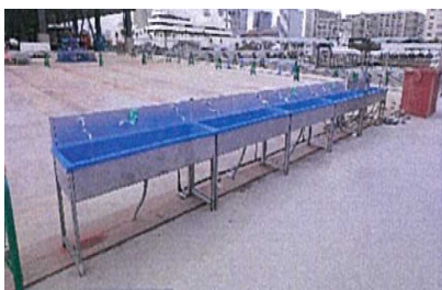
現場の手洗い場所の増設
