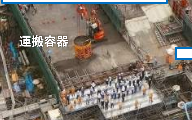
目標地点までケーブルクレーンの自律運転で揺動を抑えて運搬・放出
