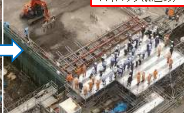
バイバックによるコンクリート締固め動作の自動化を実現
