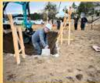
掘削はスコップを用いて人力作業
