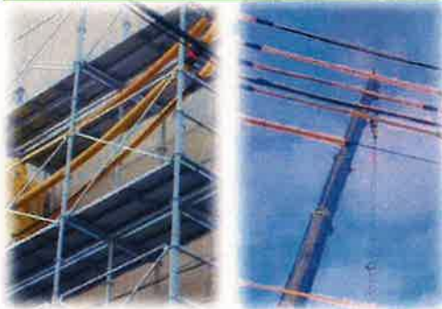
防護管取付箇所
