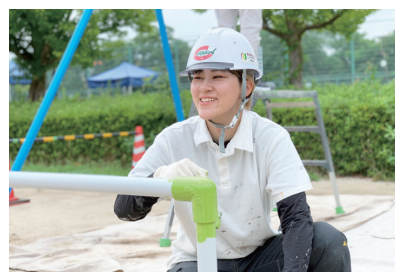
▲塗装工事の作業風景
