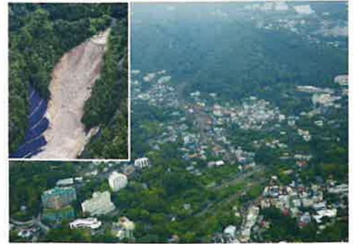
R3.7 静岡県熱海市 死者28名、住宅被害98棟
