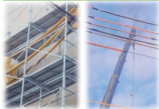
防護管取付箇所
