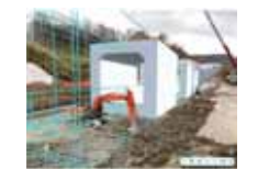
掘削作業時にARと比較
