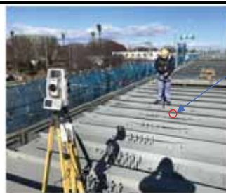
(TSを用いた計測状況写真)
