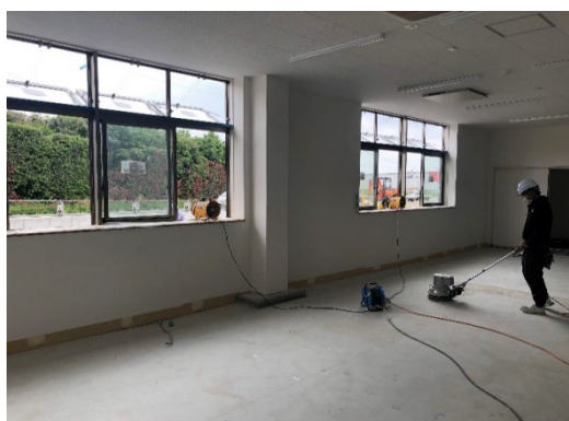
【写真①】送風機による換気(室内側)
