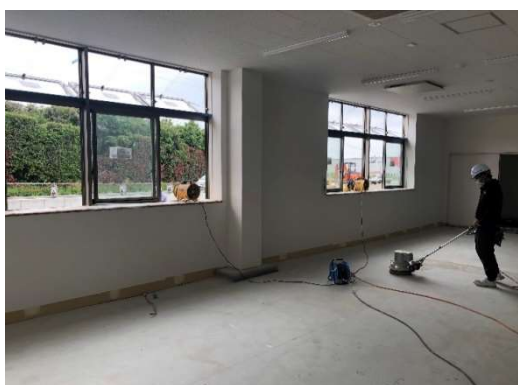
【写真①】送風機による換気(室内側)
