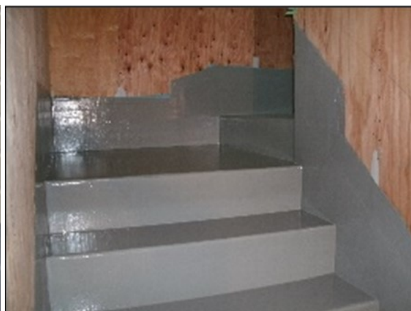
写真 1.2.2 屋外階段の 塗膜防水施工の事例
