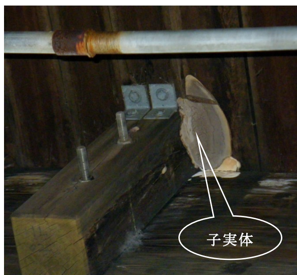
写真 2.2.6 木材腐朽菌の子実体の事例
